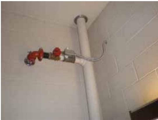
Fig. 2.4.A.22 – Stairwell stand pipe
