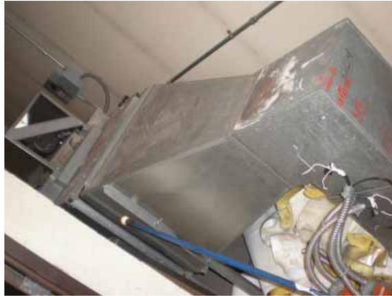
Fig. 2.4.A.24 – In-line toilet exhaust fan
